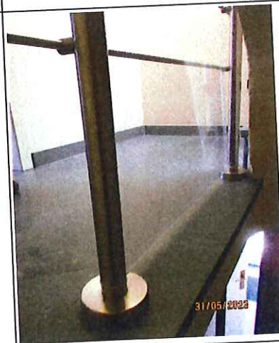
Foto 12: Opening borstwering traphal met plexiglas
